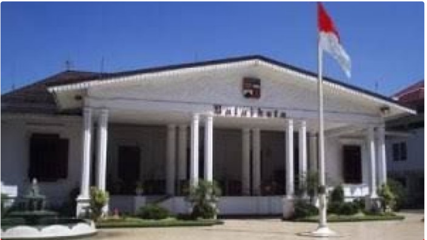
Photo Gedung Wali Kota Bogor
